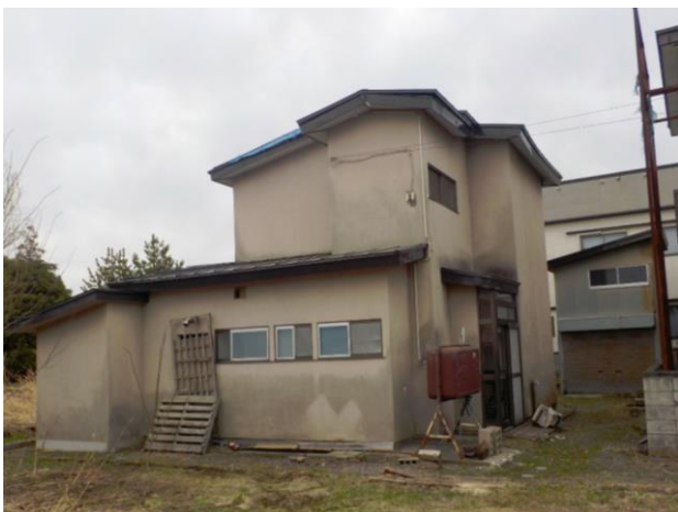
(12) 写真 (外部・内部)
