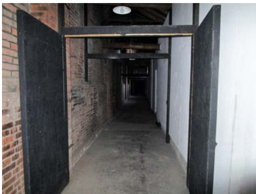
C-15 2号倉庫北側下屋：西方向
