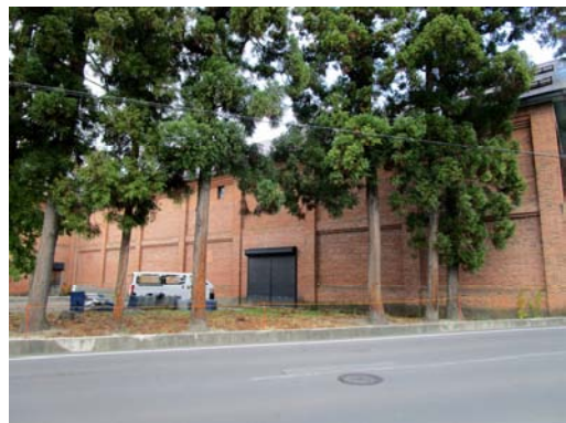
A-16 3号倉庫：西側
