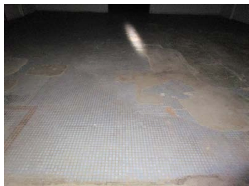
C-8 2号倉庫：②室 床(タイル)
