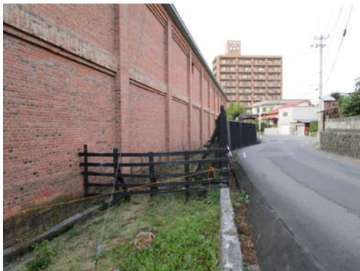
A-13 3号倉庫：南東側より
