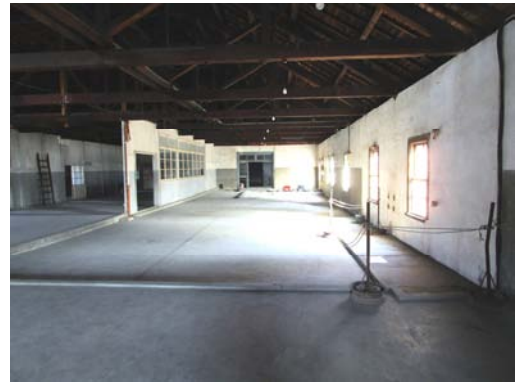
C-42 2号倉庫2階：東側
