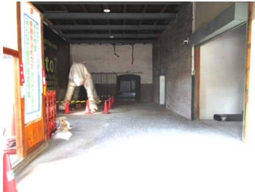
C-1 2号倉庫：西側通路
