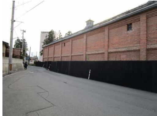
A-12 3号倉庫：南東方向
