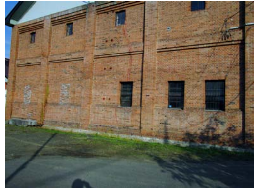
A-2 2号倉庫：西側
