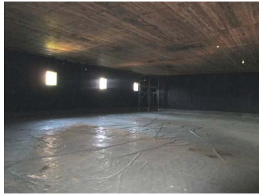
C-50 3号倉庫2階：北東側
