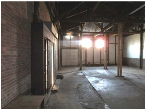
C-29 1号倉庫前室：南側より
