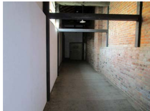
C-14 2号倉庫北側下屋：東方向
