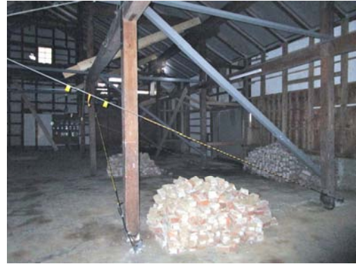
C-34 1号倉庫：南東側
