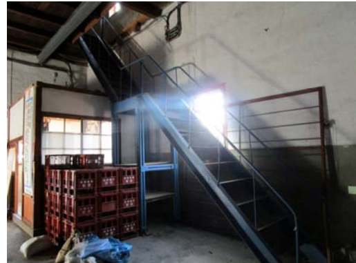
C-38 2号倉庫：階段
