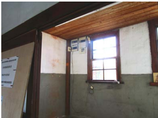
C-39 2号倉庫：事務室
