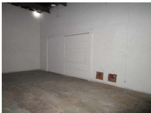
C-7 2号倉庫：②室 南側
