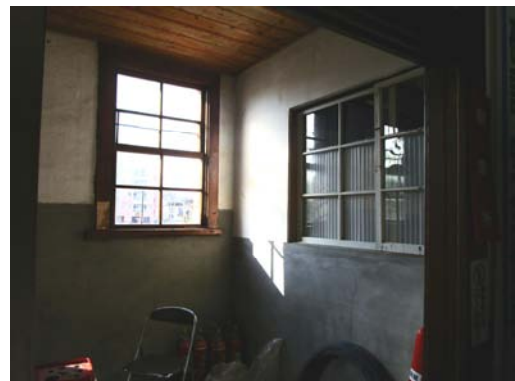
C-40 2号倉庫：事務室
