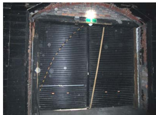
C-24 3号倉庫：西側 シャッター
