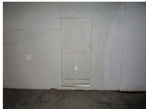
C-16 2号倉庫北側下屋：廊下(2)跡
