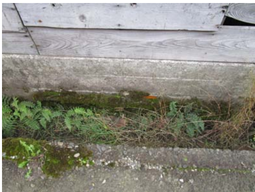
D-1 2号倉庫北側：排水口
