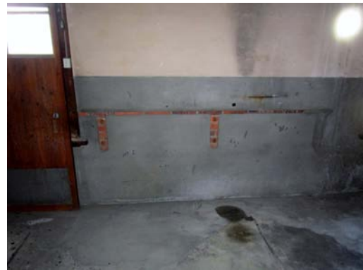
C-44 2号倉庫2階：第一研究室(流し跡か)
