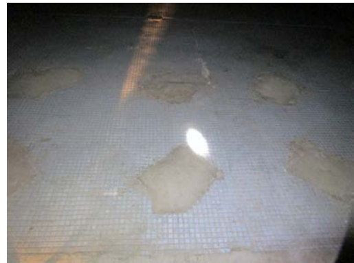
C-12 2号倉庫：③室 床(タイル)
