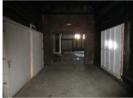
C-26 廊下(1)：南側より
