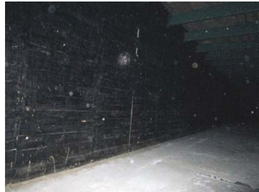
C-20 3号倉庫：東側
