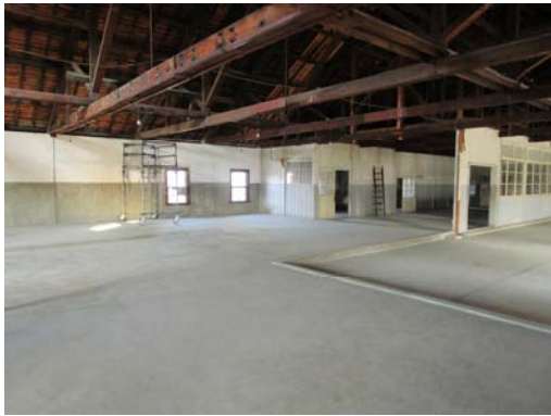
C-41 2号倉庫2階：北東側
