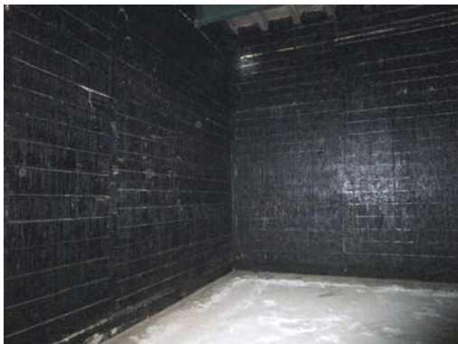
C-21 3号倉庫：南東側
