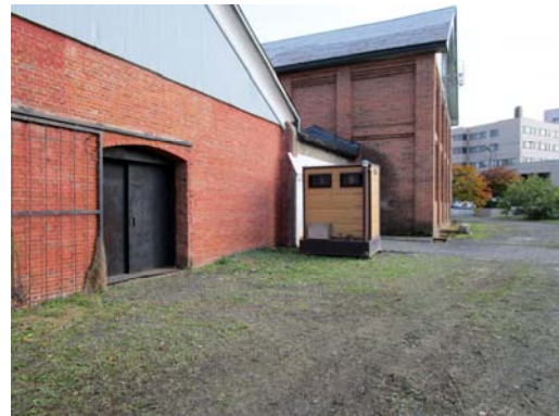
A-4 1号倉庫：西側
