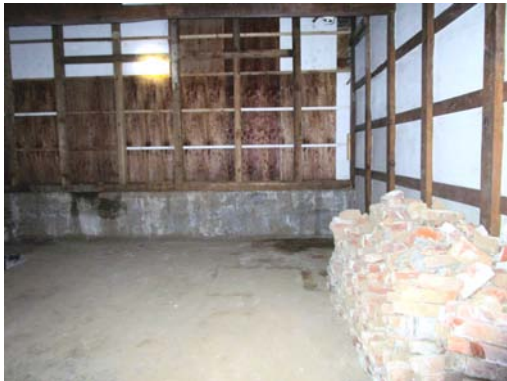
C-35 1号倉庫：南西側
