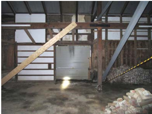
C-37 1号倉庫：廊下(2)跡 シャッター
