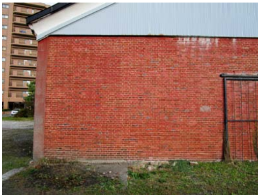
A-5 1号倉庫：西側
