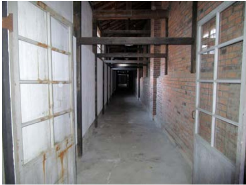
C-17 2号倉庫北側下屋：西端より
