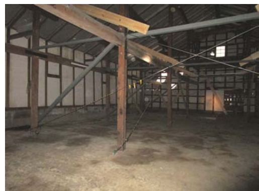
C-32 1号倉庫：北東側
