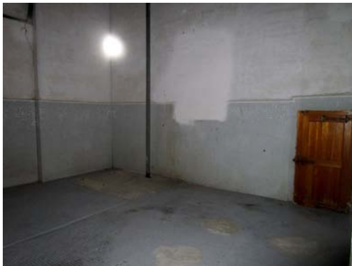
C-11 2号倉庫：③室 南東側
