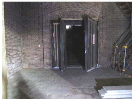
C-4 3号倉庫：入口
