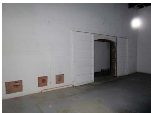
C-6 2号倉庫：②室 北側
