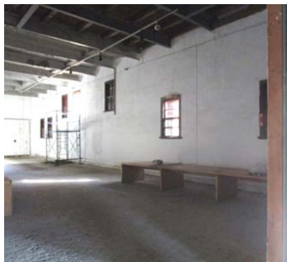
C-3 2号倉庫：南窓側
