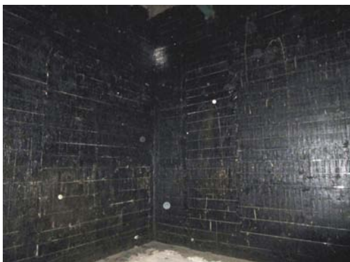
C-23 3号倉庫：南西側
