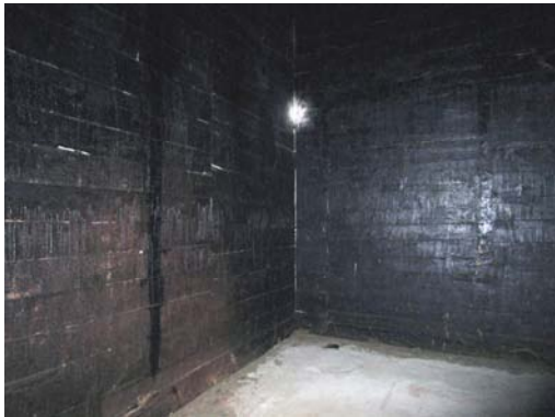
C-19 3号倉庫：北東側
