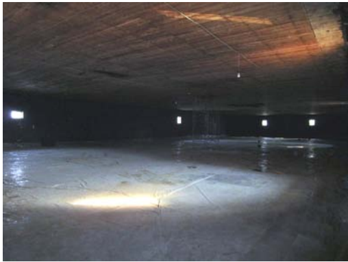
C-49 3号倉庫2階：南東側
