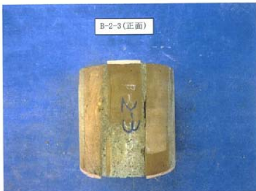
写真-93 目地モルタルの破壊状況 (正面) [B-2-3]
