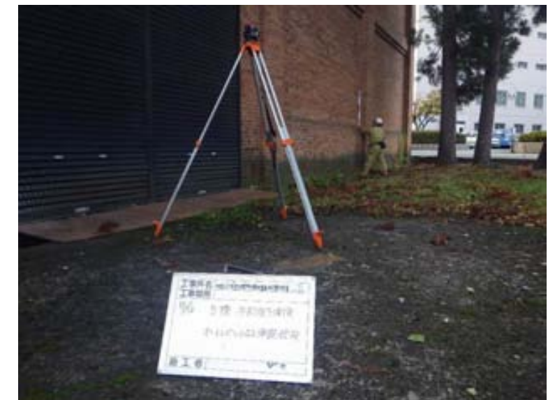
レベル測定状況写真(B棟)
