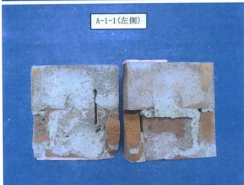
写真-49 目地モルタルの破壊状況 (写真-48 左側) [A-1-1]
