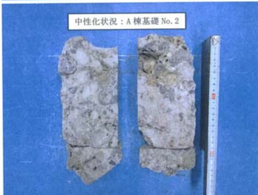
写真-5 中 性 化 状 況 [A棟基礎No. 2]
