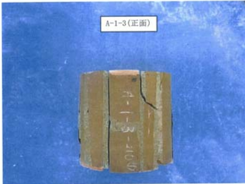
写真-54 目地モルタルの破壊状況 (正面) [A-1-3]
