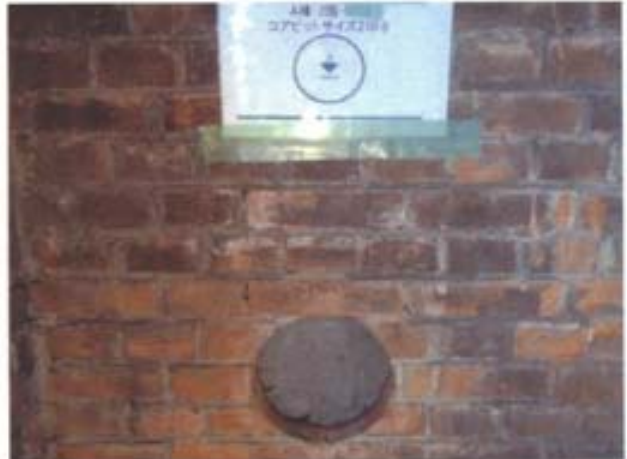
④削孔部穴埋め
