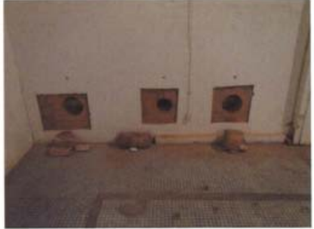
④削孔部穴埋め
