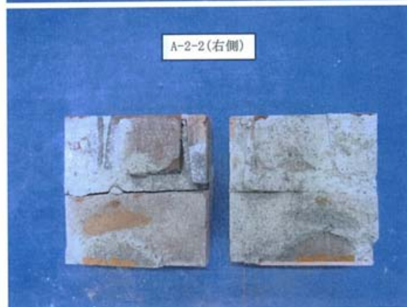
写真-68 目地モルタルの破壊状況 (写真-66 右側) [A-2-2]
