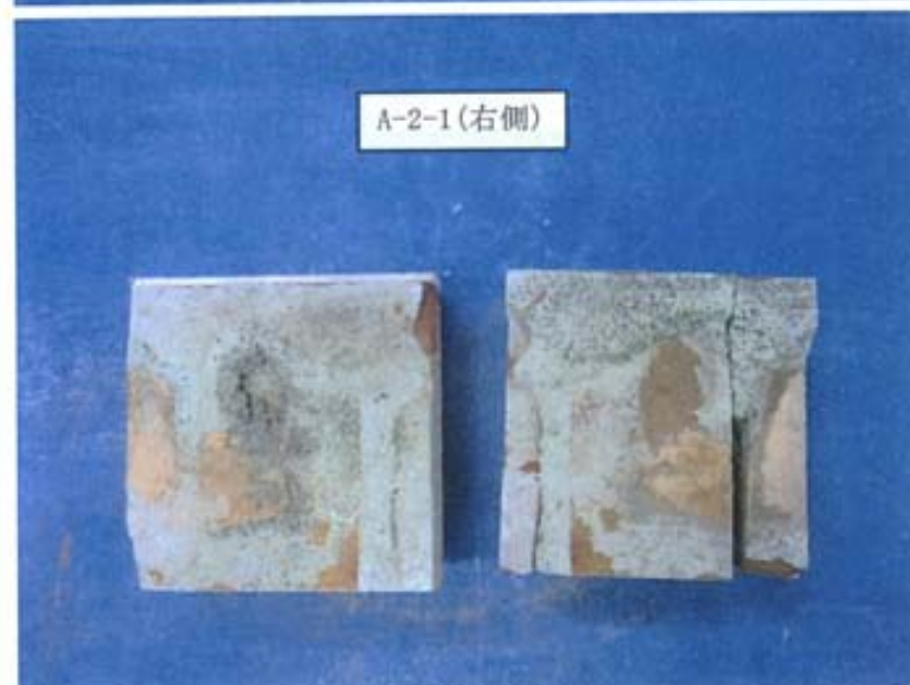
写真-65 目地モルタルの破壊状況 (写真-63 右側) [A-2-1]
