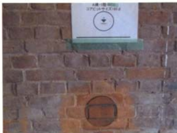
⑤補修完了
