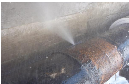
老朽化した水道管からの漏水
