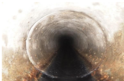
老朽化した下水管の内部
