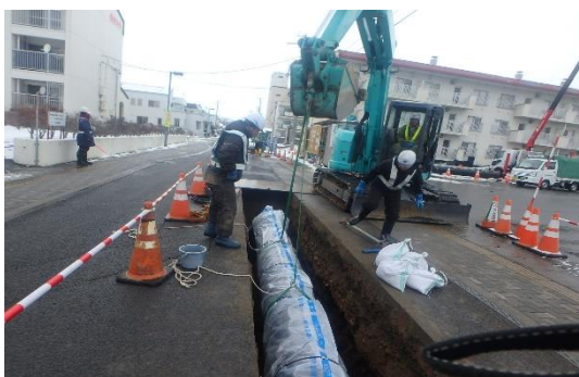
水道管の布設替工事
