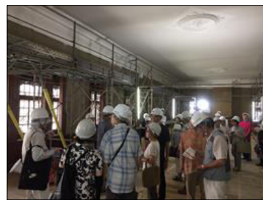
旧弘前偕行社修理現場公開
