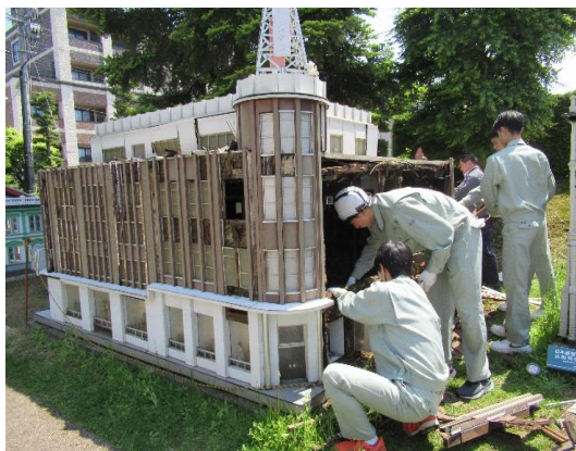
【ミニチュア建造物修理作業状況①】
