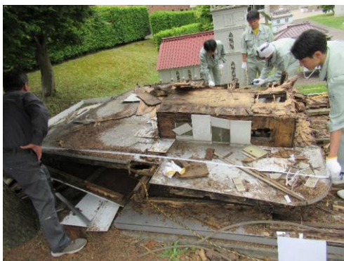
【ミニチュア建造物修理作業状況②】
