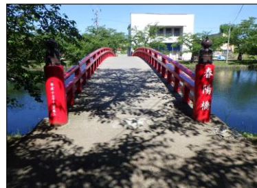
【春陽橋木部更新状況】
