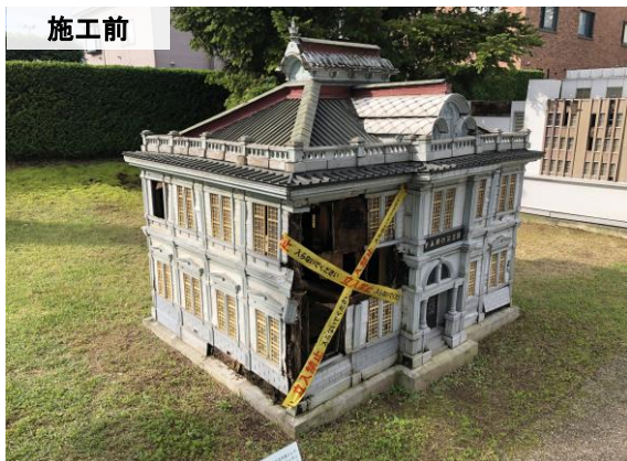
【ミニチュア建造物修理前後状況】
