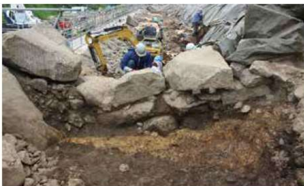
暗渠部では裏込めの上に盛土が盛られ、掘方が掘られている
