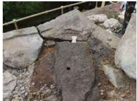
写真7 口八角-2・2'の子キリ・ダボとロー12の段差加工
