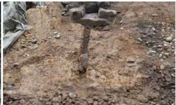
底石解体状況(東から)
