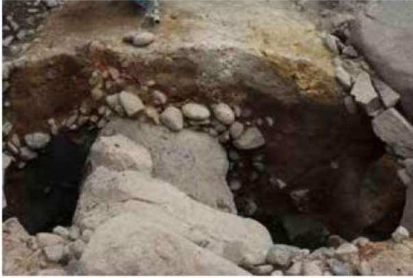
写真18 明治29年(1896)の石垣崩落で前面に押し出された内濠石垣(慶長期)背面の盛土と栗石
