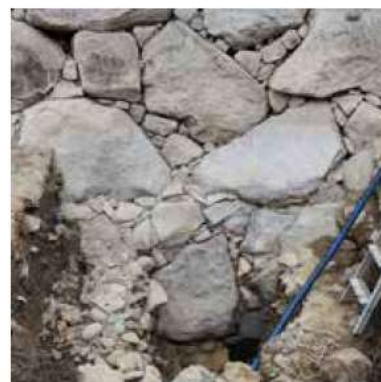
写真5 JトレンチI期石垣
