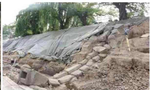
蓋石解体状況(北東から)
