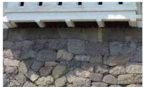
写真10 V期石垣(天守台下の谷落とし積み)
