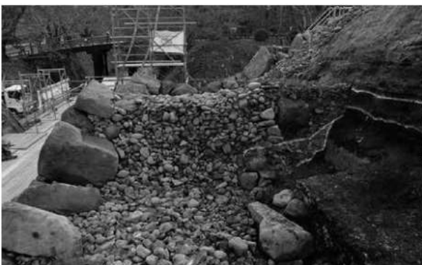
S1セクション(11・12段目)(北から)
