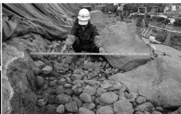
I期石垣イ-610背面裏込め幅(南から)
