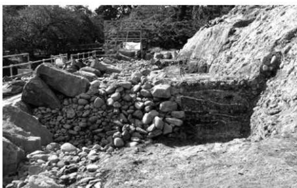
S2セクション(5~7段目)(北から)
