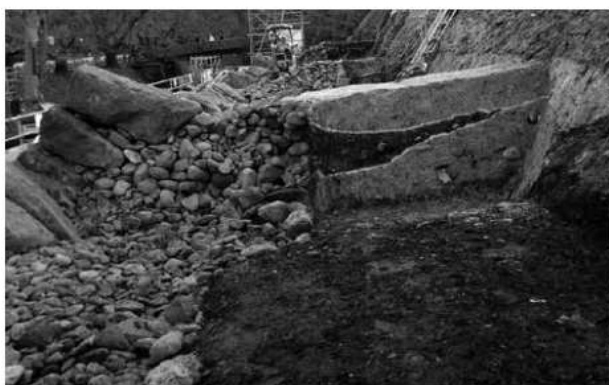
S3セクション(6~8段目)(北から)
