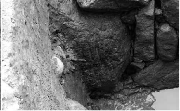
I トレンチノミ切り加工が施された内濠石垣（慶長期）の築石（東から）
