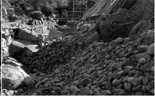
S 3 セクション (16 ~ 18 段目) (北から)
