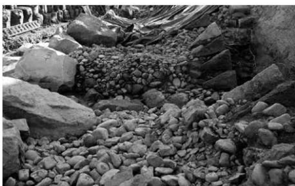
S2セクション(18・19段目)(北から)
