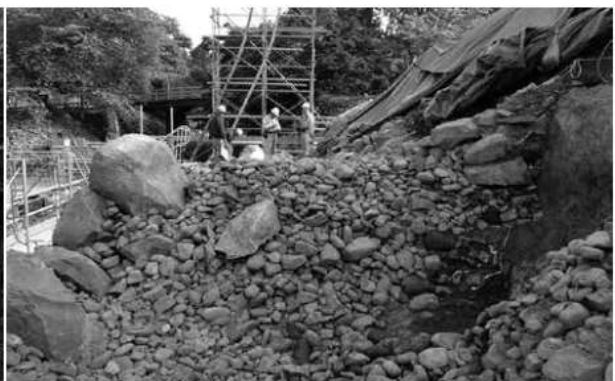
S1セクション(16~18段目)(北から)
