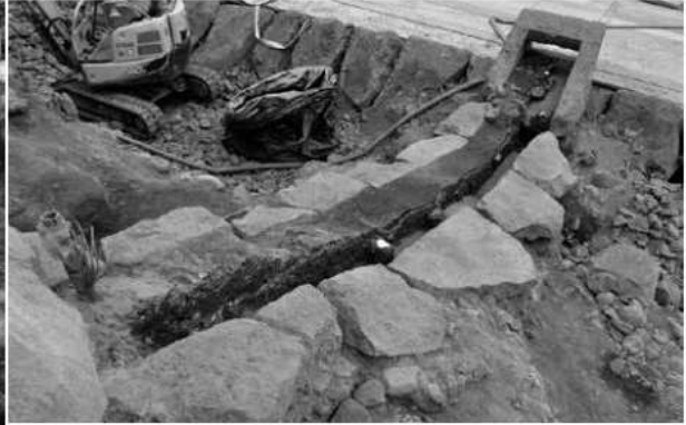
排水遺構2(暗渠部)セクション(南西から)
