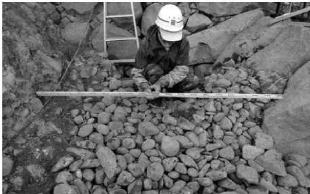
Ⅲ期石垣イ-12-89 背面裏込め幅（南から）
