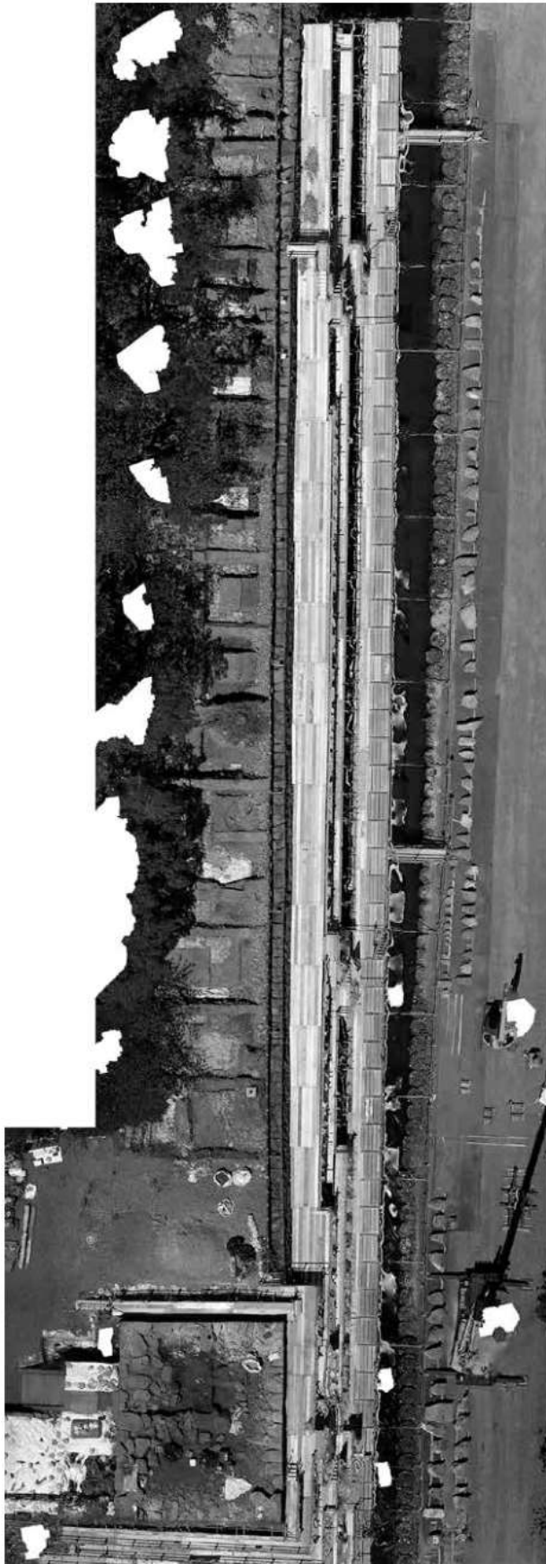
天守台天端～3段目・本丸天端検出状況（南から）
