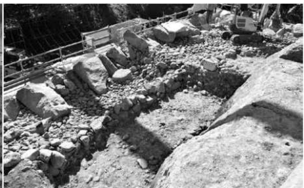
天守台Ⅴ期石垣7段目押石検出状況（北西から）
