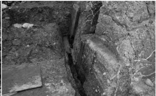
井戸跡北側土留め板検出状況①（南東から）
