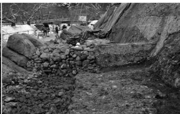
S3セクション(8~10段目)(北から)
