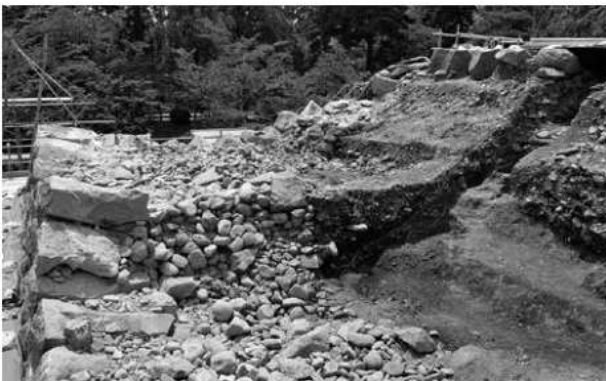
S1セクション(4~6段目)(北東から)
