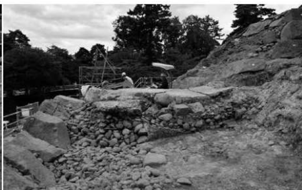
天守台V期石垣北面下コンクリート基礎検出状況（北から）
