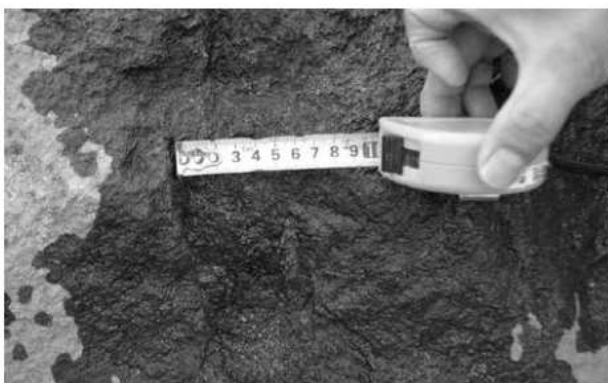
V期石垣築石矢穴痕
