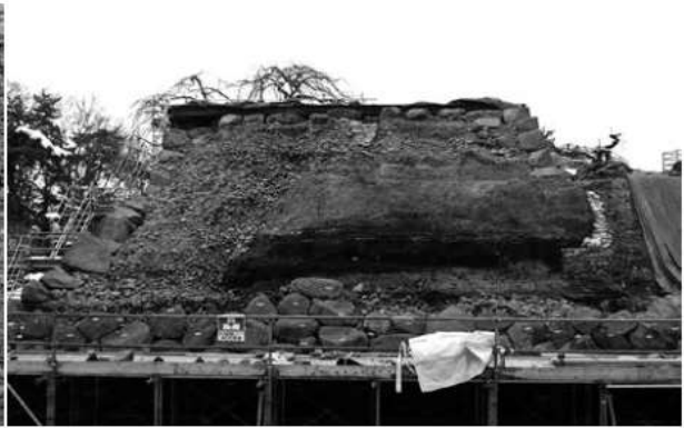
天守台11段目解体状況(東から)
