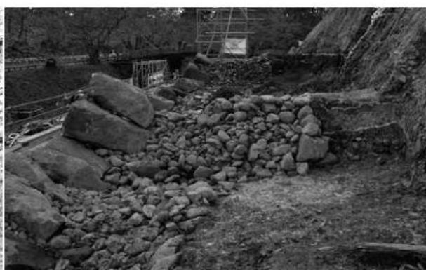
S2セクション(7・8段目)(北から)
