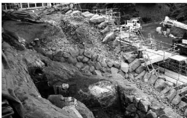
埋没石垣検出状況(南西から)
