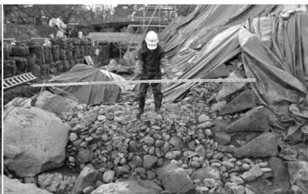
イ-443 背面V期石垣裏込め幅（北から）
