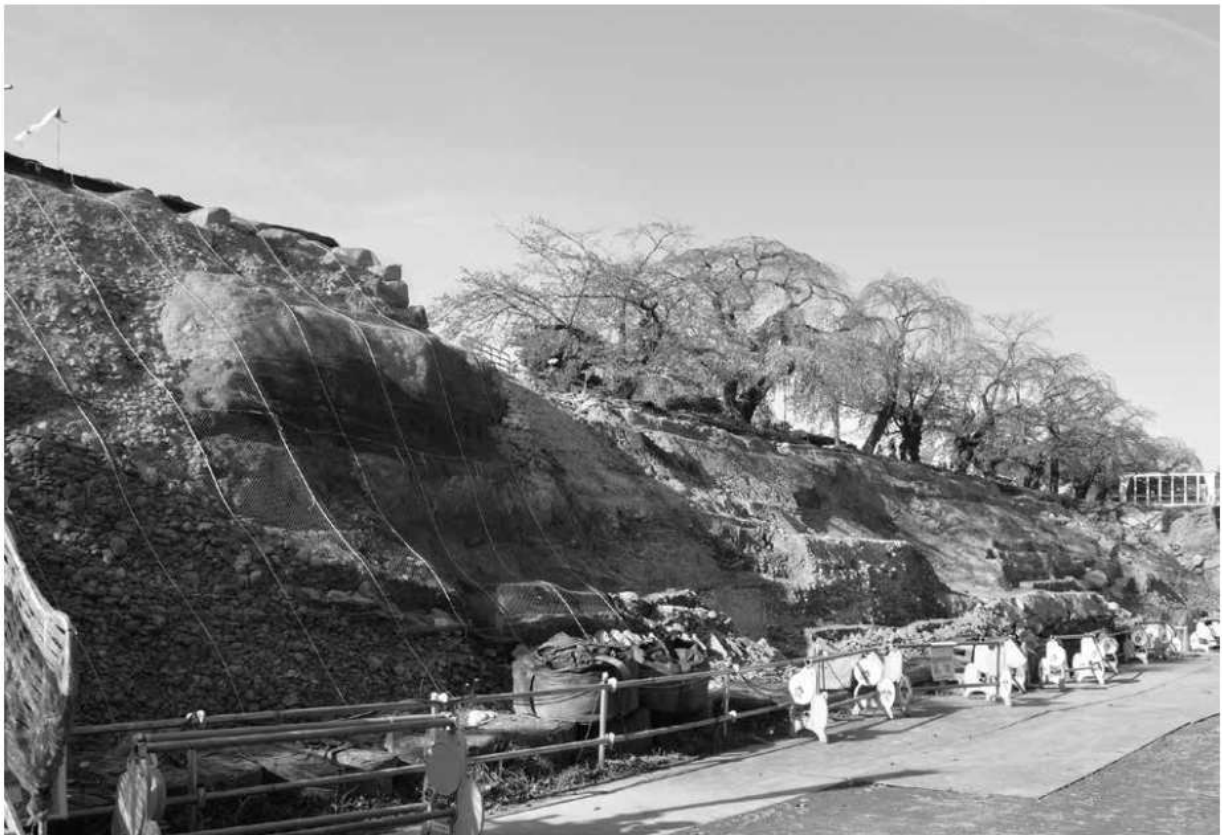
石垣解体終了状況(南東から)
