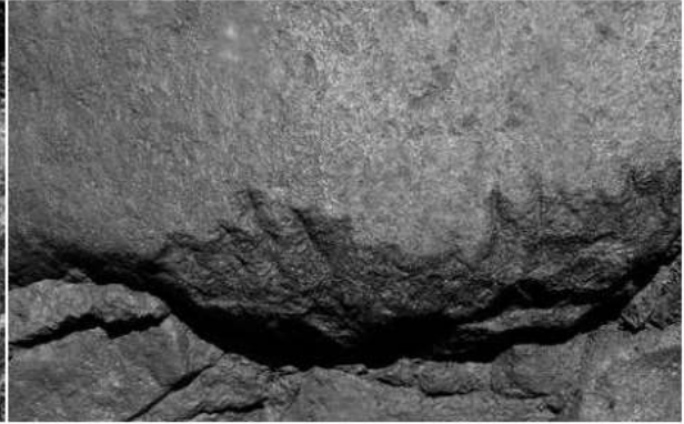
Jトレンチ大正4年(1915)の石垣修復工事でノミ切り加工が施されたI期石垣築石(南から)
