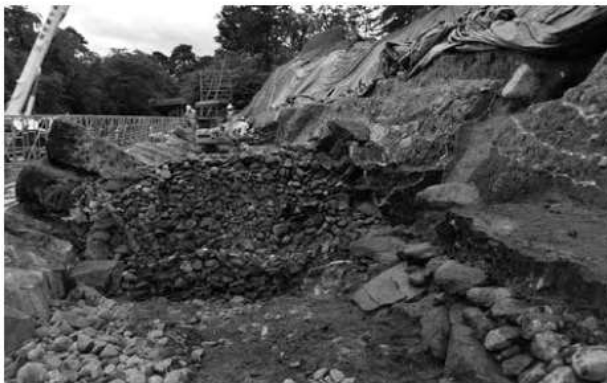
S 4 セクション (12 ~ 14 段目) (北から)
