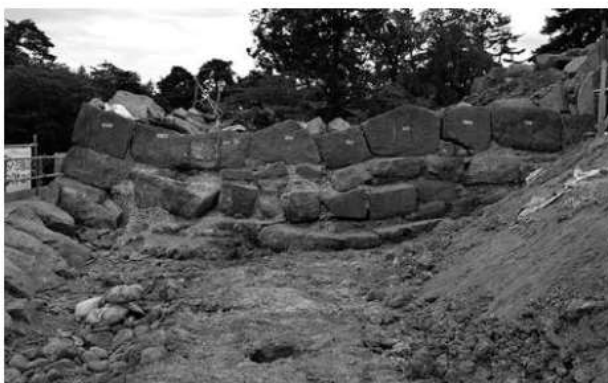
天守台V期石垣北面検出状況（北から）
