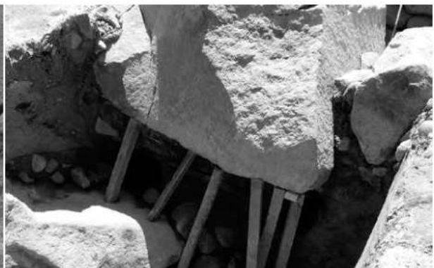
Gトレンチ胴木5検出状況（北東から）
