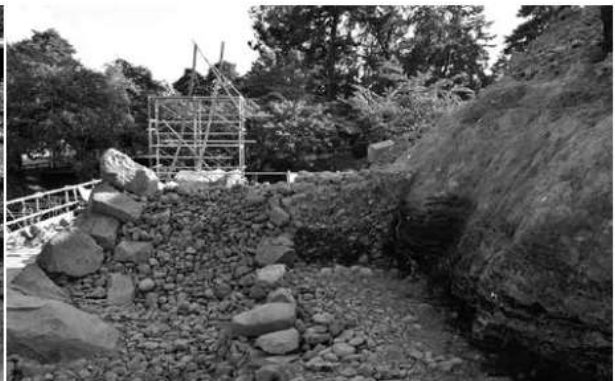
S1セクション(8~10段目)(北から)
