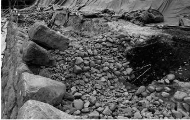
S 3 セクション (11 ~ 13 段目) (北東から)
