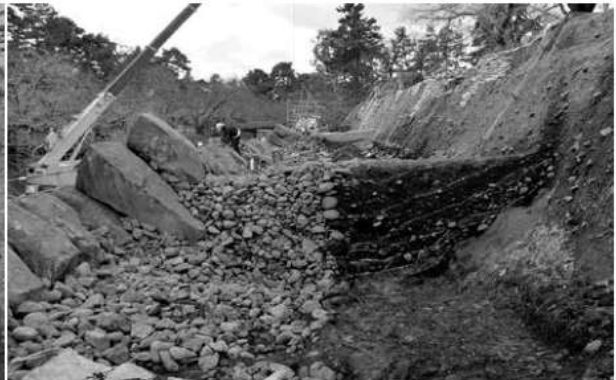
S 4 セクション (6 ~ 8 段目) (北から)
