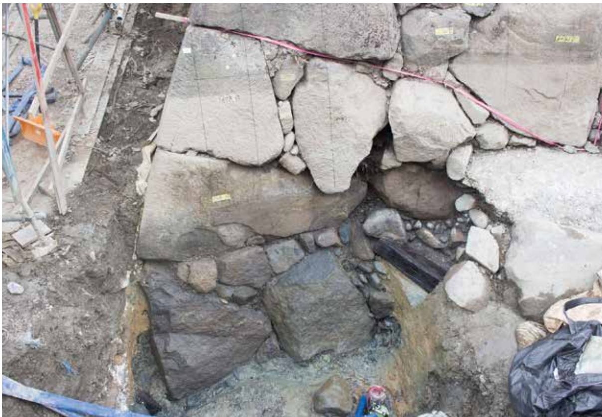
本丸石垣南東隅角部根石検出状況(東から)
