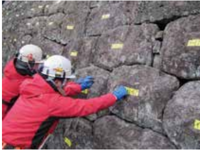
写真1 築石墨入れ状況
