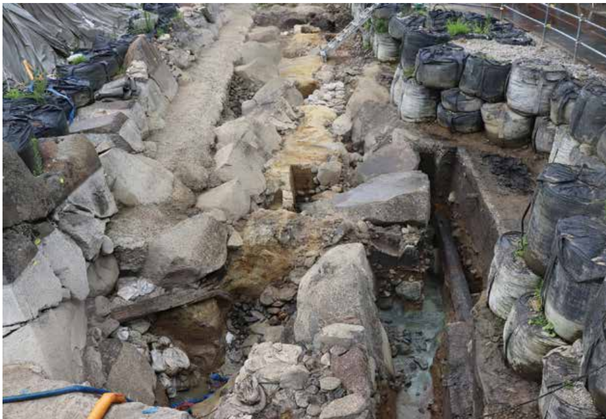
明治29年(1896)の石垣崩落で滑り出した本丸石垣の根石と押し出された内濠石垣(南から)
