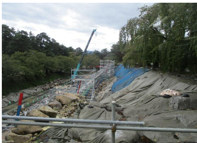
石垣普請番屋から工事現場を望む
