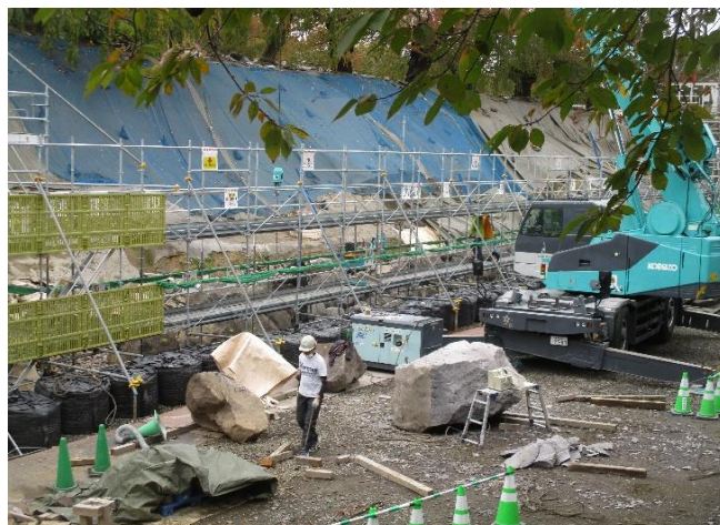
石垣積直し現場（令和3年10月26日撮影）
