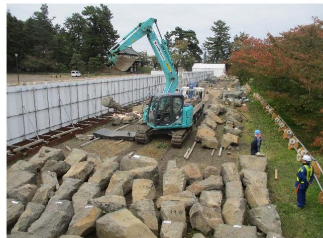
四の丸から石材運搬（令和3年10月26日撮影）
