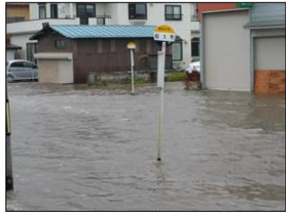
[平成 25 年 9 月 市道冠水]
