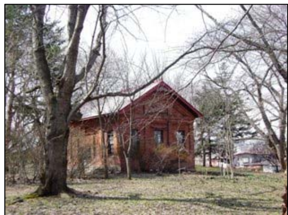
旧福島醸造変電所
