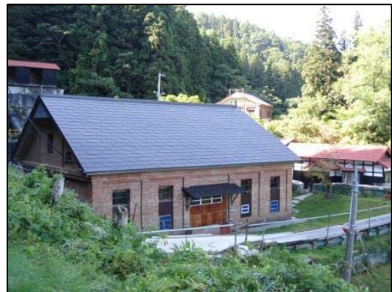
旧福島酒造発電所（吉井酒造発電所）
