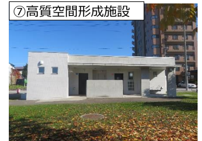
バリアフリー対応 公衆トイレ
