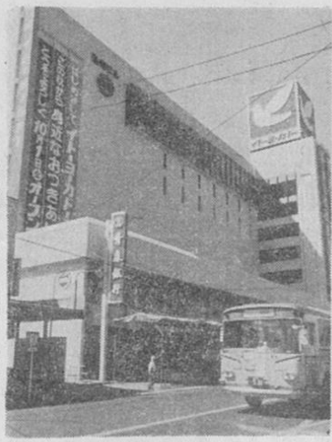
東側(右)と西側からみた弘南ビル正面
