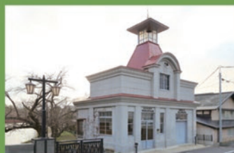
18 旧弘前市消防団西地区団第四分団消防屯所 [紺屋町 2-2 昭和 8 年頃建築] 高さ 14.3 m の火の見櫓がある洋風の外観が洒落た建物。当時の名士の寄付により建築されました。
