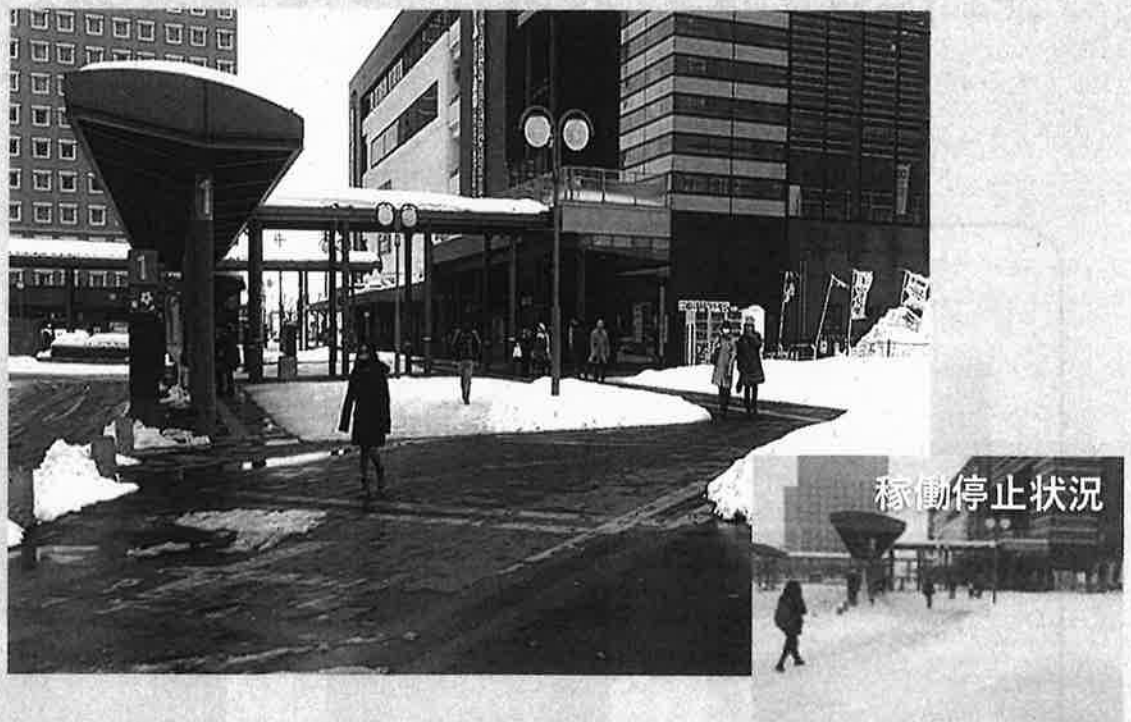
歩道融雪の稼働状況【弘前駅前地区】
