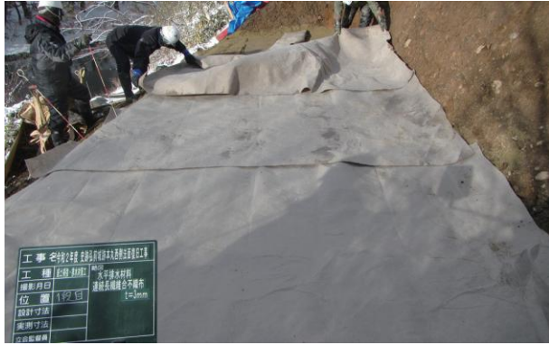
本丸西側法面水平排水材敷設状況(南から)
