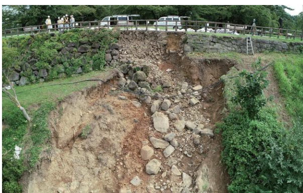
本丸西側法面及び本丸西面石垣崩落状況②(西から)
