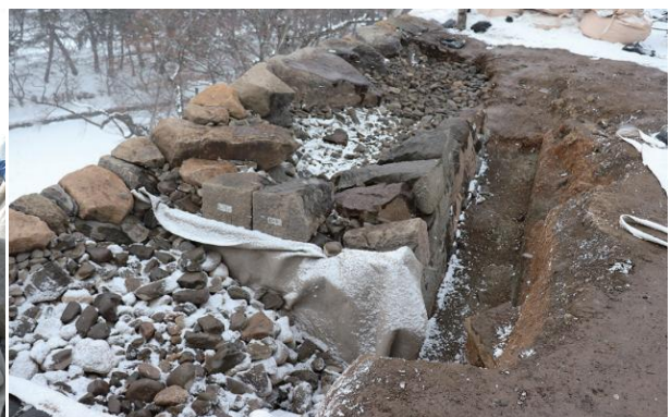
本丸西面崩落部及び本丸西方埋門跡通路部栗石充填状況(南東から)
