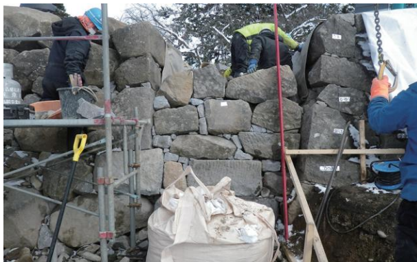
本丸西面石垣（本丸西方埋門跡閉塞部）復旧作業(西から)
