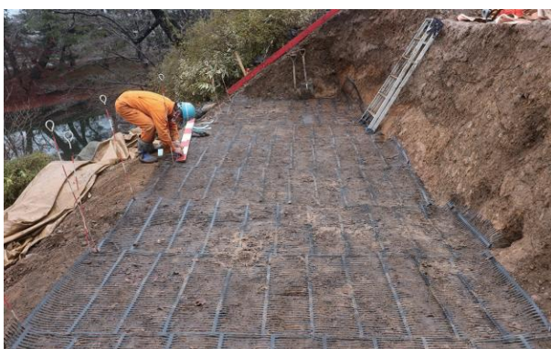
本丸西側法面盛土補強材敷設状況(南から)
