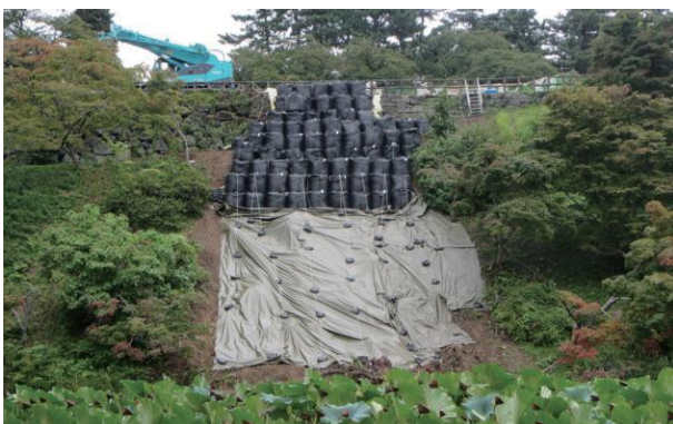
令和2年度大型土嚢設置状況(西から)
