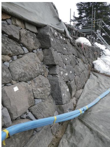
写真8 セットバックにより生じたズレ
