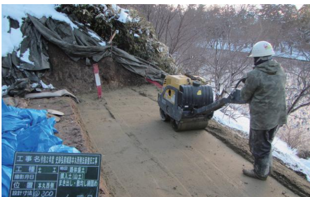
本丸西側法面盛土締固め状況(北東から)
