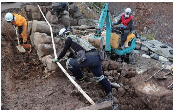
令和3年度崩落栗石撤去状況(北東から)
