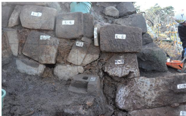
埋門本柱を固定するためにスリット状に加工された築石(E-4・8・9)(北から)
