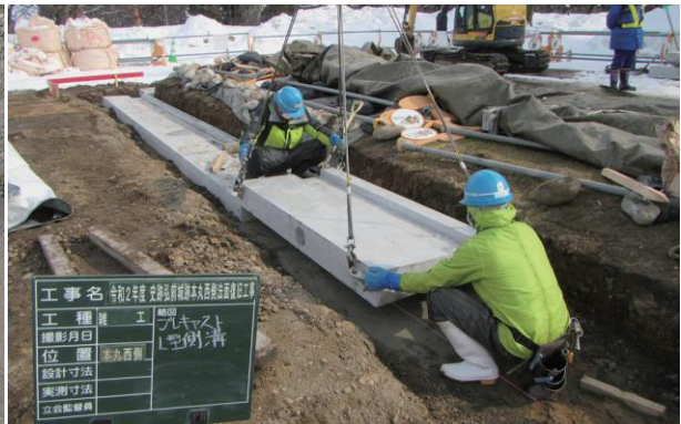
園路側溝新設作業(南西から)
