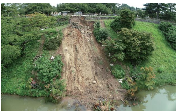
本丸西側法面及び本丸西面石垣崩落状況①(西から)
