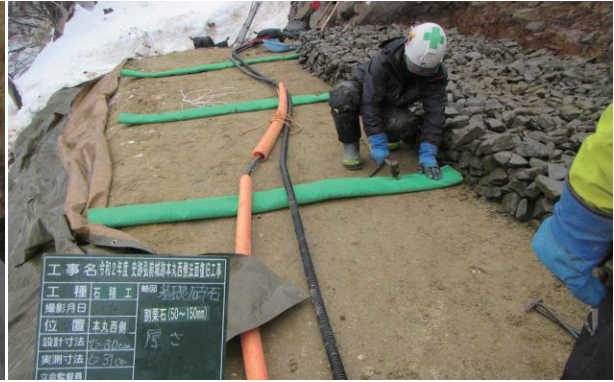
本丸西側法面暗渠排水材設置状況(南から)
