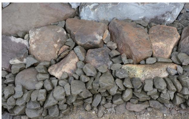
本丸西面石垣根石押石設置状況②(西から)
