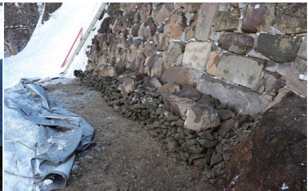
本丸西面石垣根石押石設置状況①(南西から)
