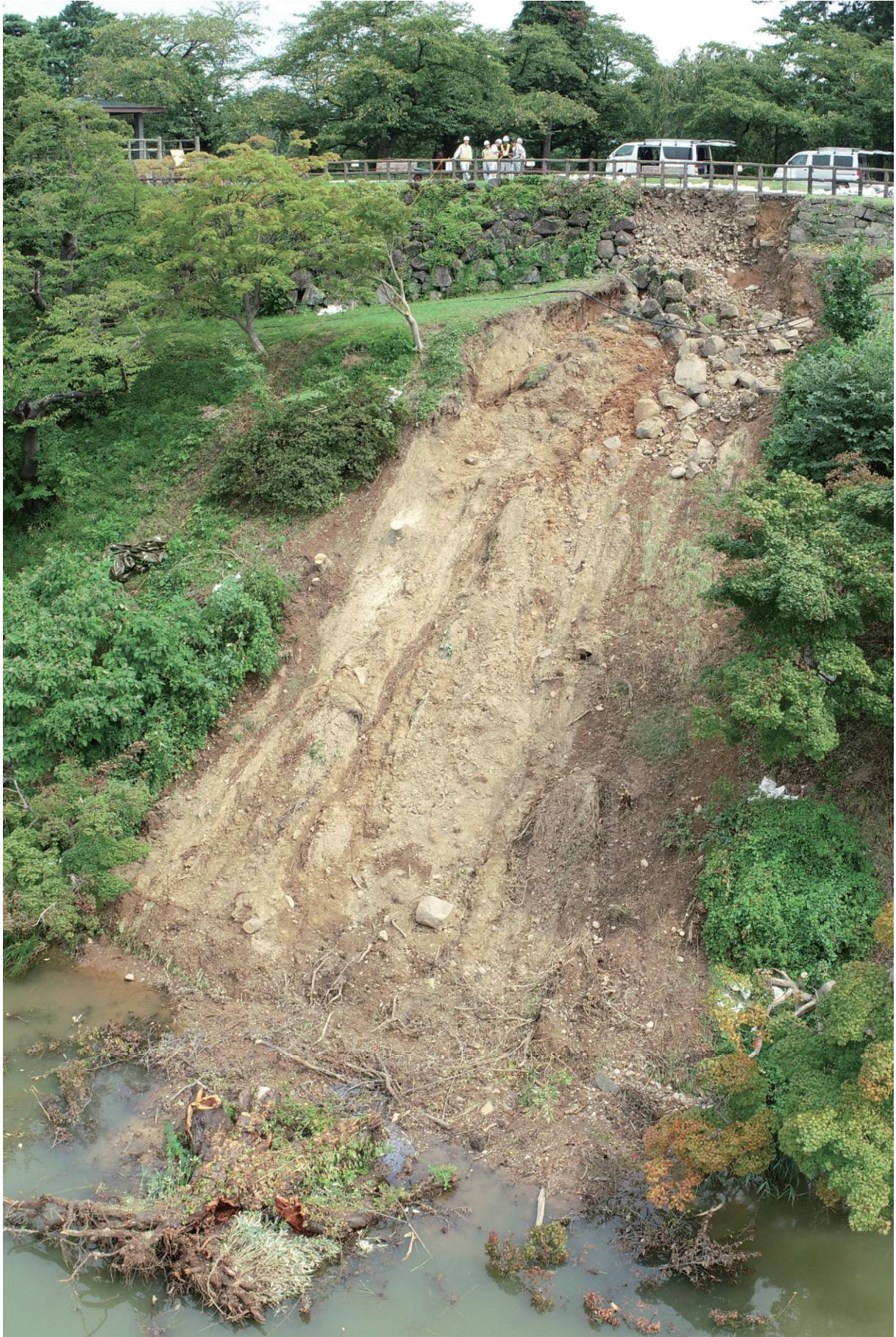
本丸西側法面及び本丸西面石垣被災状況遠景(西から)
