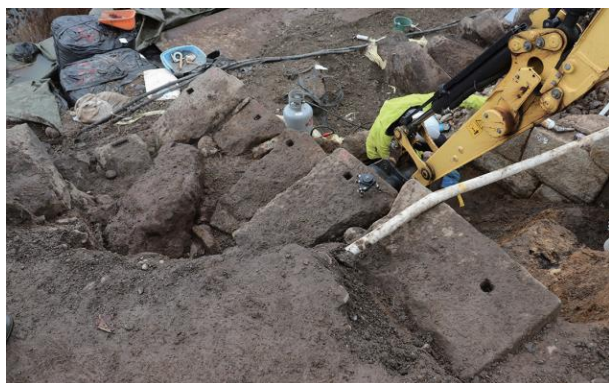
石垣E面築石上面ダボ穴確認状況(南東から)
