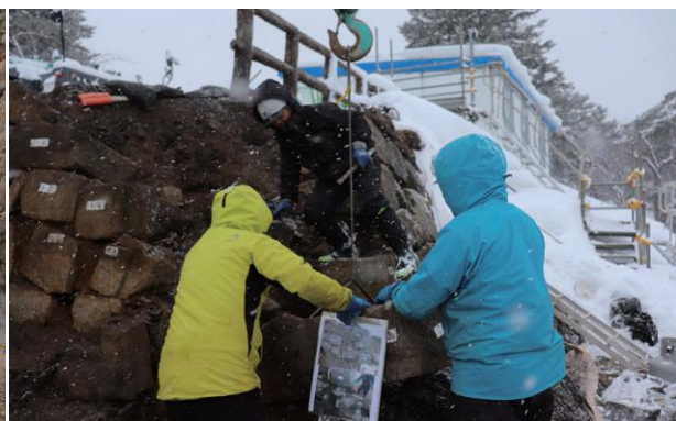
石垣D・E面横直し状況(北西から)
