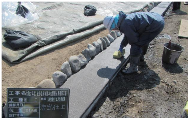
園路側溝洗い出し仕上げ作業(北西から)
