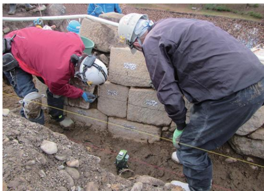
写真3 石垣解体前築石墨入れ状況
