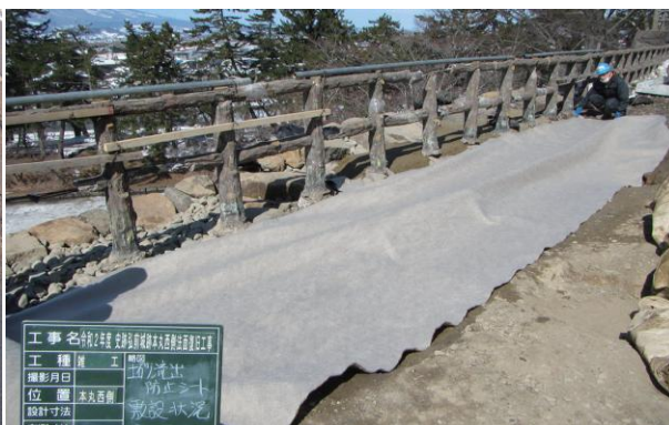
本丸石垣背面土砂流出防止シート敷設状況(南東から)
