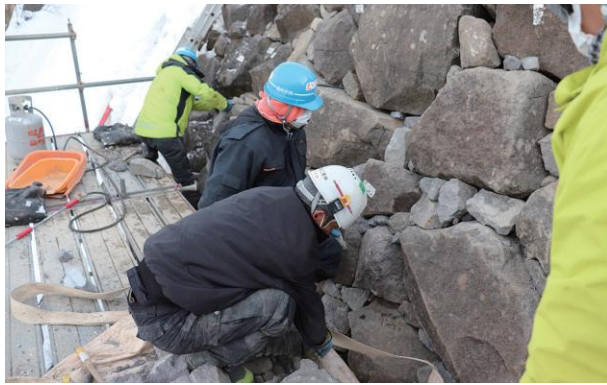
石垣A面間詰石充填作業(南西から)
