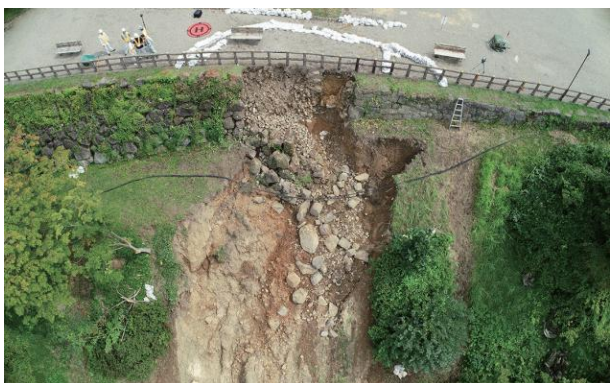
本丸西側法面及び本丸西面石垣崩落状況③(西から)
