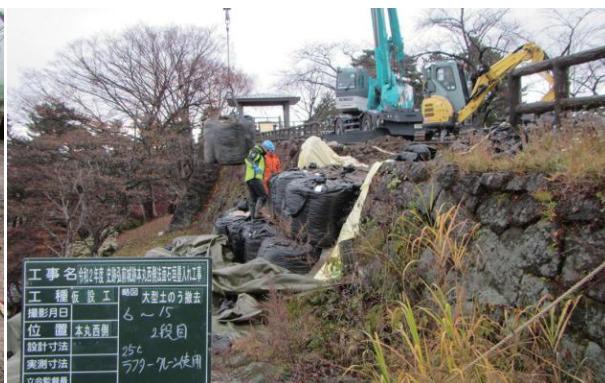
大型土嚢撤去状況(南西から)
