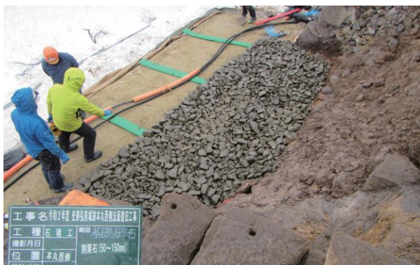
本丸西側石垣下基礎栗石設置状況(南東から)
