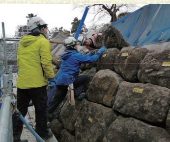
▲13段目の積み直しと12段目仮組み作業（※7）
