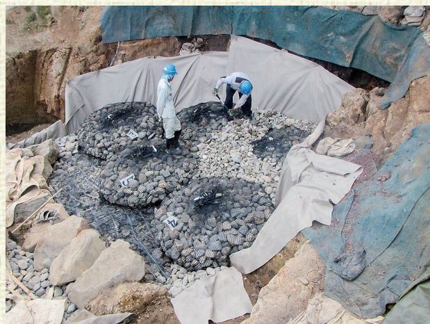
▲井戸跡に栗石を敷き詰める作業（※2）
