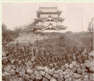
▲（※3）明治29年に崩落した石垣（市立弘前図書館蔵）
