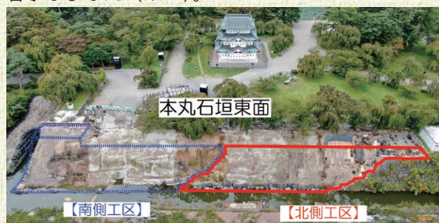
▲（※2）石垣積み直し工事の工区分け
