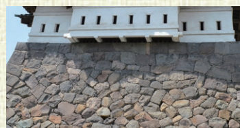
▲（※4）天守台石垣東面の谷落とし積
