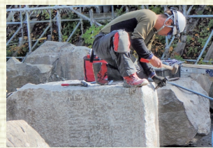
(※5) 交換石の仕上げ加工
