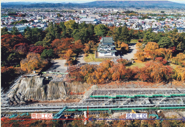
(※1) 令和5年10月末時点の石垣積直し状況
