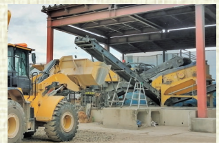
(※7) 破砕機で角礫に加工
