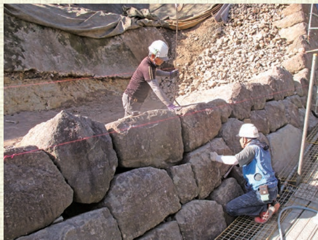
▲(※3) 丁張(ちょうはり)と石積み作業
