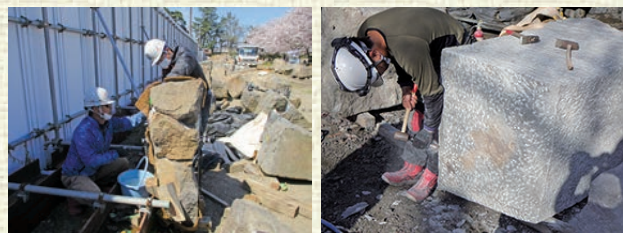
▲(※4) 割れた石の補修 ▲(※5) 交換する石の加工
