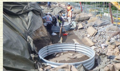
▲(※3) 天守台南東部の円形土留め設置作業
