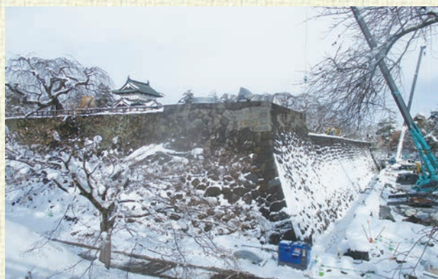
▲(※1) 天守台石垣積み直し完了(令和6年12月)
