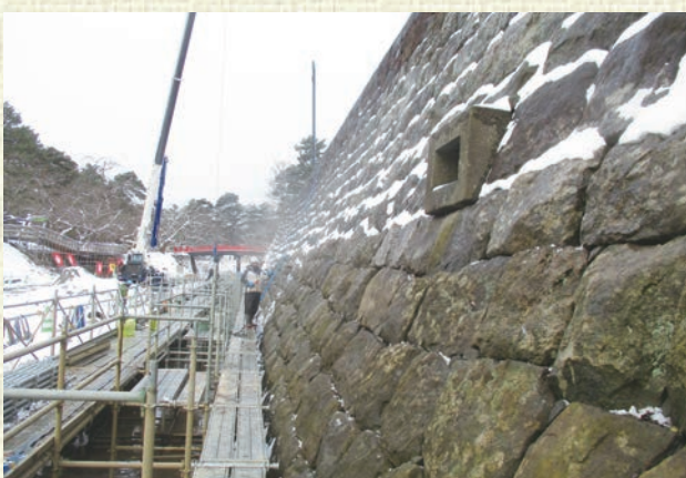
▲(※2) 復元された本丸東面石垣の勾配(令和6年12月)
