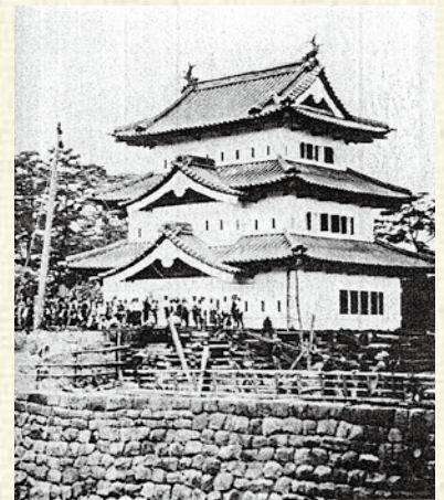
△ 100年前の天守曳屋（大正4年撮影）…100年前には人力で天守を曳屋していますが、今回は機械を用います。
