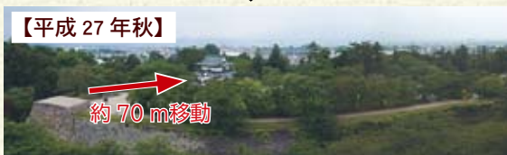
◁天守曳屋工事想定図…天守は本丸中央部へ約70m移動します（予定）。平成27年のさくらまつりまでは、現在の位置にある天守を見ることができます。また、曳屋工事中も本丸へは入場できるようになります。
