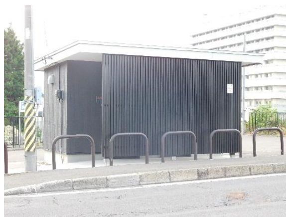
南塘町バスプール公衆トイレ
