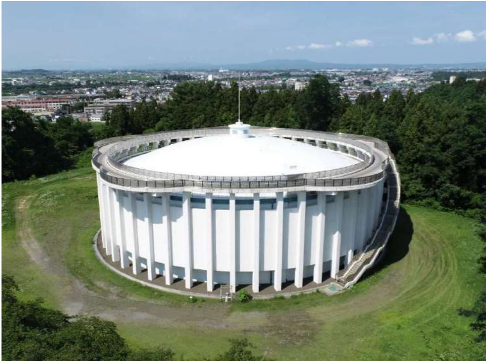
常盤坂配水池
