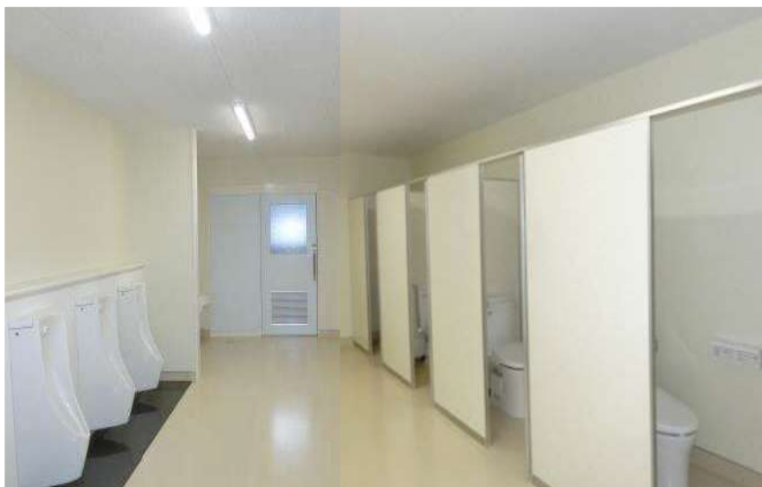
明るく、清潔感のある空間に生まれ変わった学校トイレ
