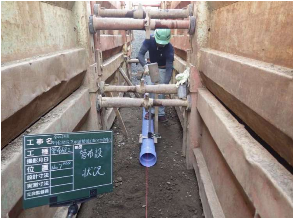
下水道工事の様子
