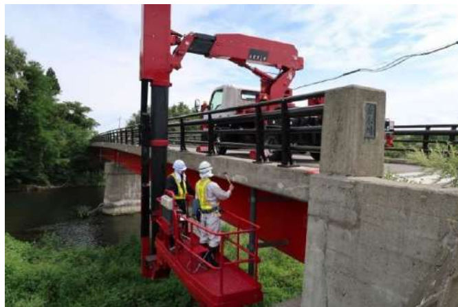
橋梁の点検の様子
