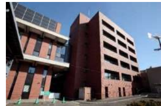
市庁舎に設置した太陽光パネル
