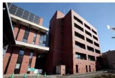
市庁舎に設置した太陽光パネル
