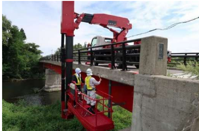
橋梁の点検の様子
