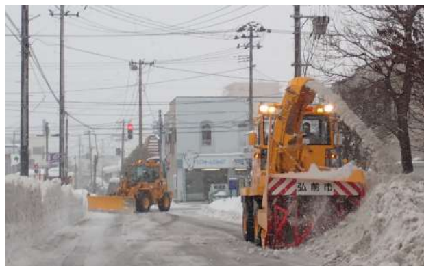
拡幅・路面整正作業の様子
