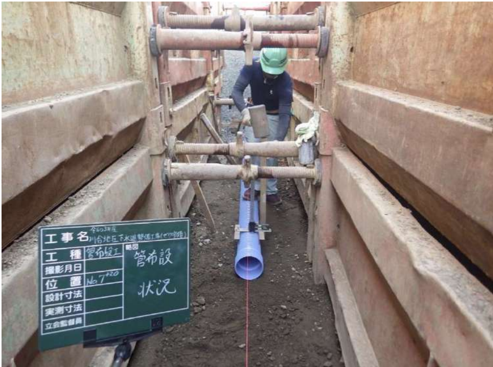
下水道工事の様子
