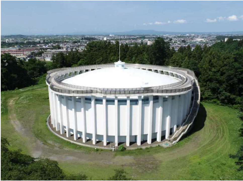
常盤坂配水池
