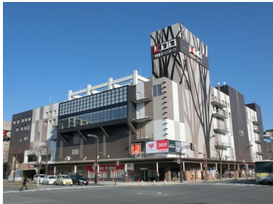
○弘前駅前地区再開発ビル再生事業(ヒロロ)
