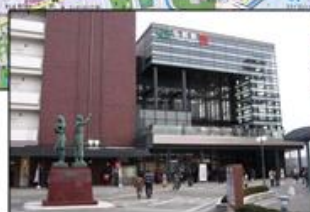
■弘前駅東西自由通路
