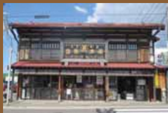
35 有限会社(農)高木静一商店 [松森町 158 昭和 4 年建築] 金文字看板が老舗の風格と趣を添えている肥料・農薬店。漆喰の天井や観音開きの窓など、昭和のまま時の流れが止まったようなたたずまいを見せている建物です。
