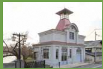
19 旧弘前市消防団西地区団第四分団消防屯所 [紺屋町 2 - 2 昭和 8 年頃建築] 高さ 14.3 m の火の見櫓がある洋風の外観が洒落た建物。当時の名士の寄付により建築されました。
