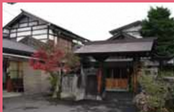
09 平野 [徒御川端町 7 大正期建築] 土淵川沿いにたたずむ門構えが目を引く建物。大正時代に民家として建てられた建物ですが、昭和 30 年から割烹として営業されています。
