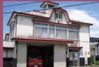
25 茂森会館消防西第一分団 [西茂森 1 丁目 1 昭和 11 年建築] 禅林街入口の桁形に位置し、望楼付きの洋風デザインが目目を惹く建物です。
