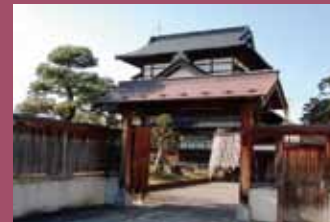
26 下山家住宅 [茂森新町 3 丁目 1-3 昭和 20 年建築] 正面玄関側に切妻型の大きな屋根、白漆喰の妻壁に格子状の梁や束が美しい「吾妻建ち」の特徴を残した建物です。
