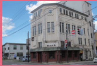
06 三上ビル (旧弘前無尽社屋) [元寺町 9 昭和 2 年建築] 登録有形文化財。東北でも初期の鉄筋コンクリート造の建物。オールデコ調のデザインが洒落た社屋ビルです。
