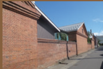
37 弘前銘醸煉瓦倉庫 【富田3丁目 7-1 大正7年建築】
