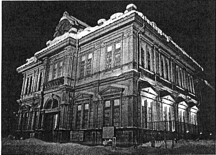
側面に投光器が新設され、立体的に浮かび上がる 第五十九銀行本店本館＝10日午後6時15分
