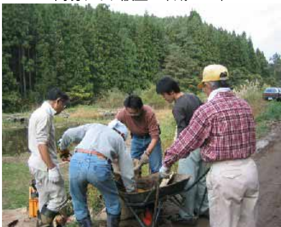
台風21号被害補修作業 平成16年
