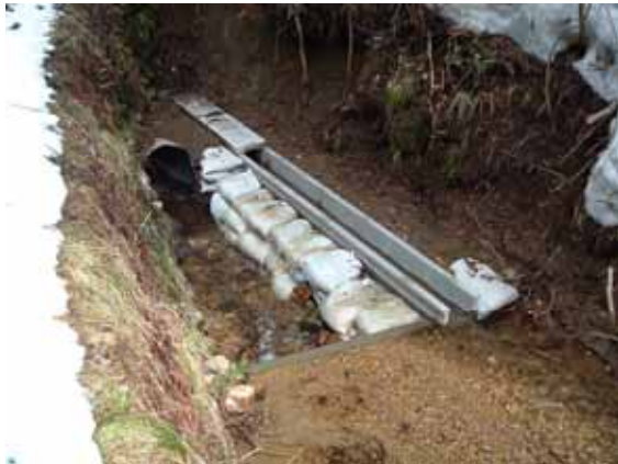
赤沢導水路整備 平成18年
