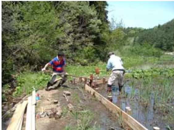
カナコ菖補修作業 平成18年
