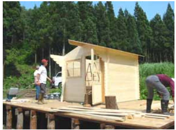
物置小屋組立作業 平成15年
