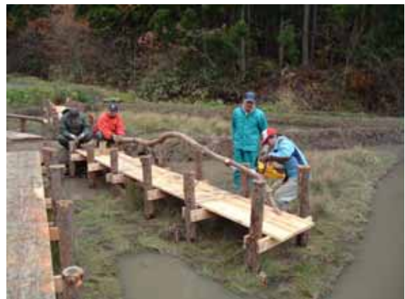
だんぶり島の池木道整備作業 平成15年
