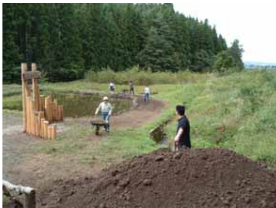
ウルメ池盛土整備作業 平成15年
