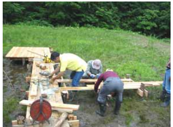
カナコ沓木道整備作業 平成15年
