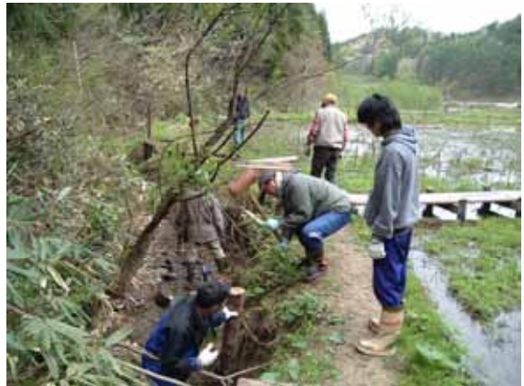
赤沢補修作業 平成18年
