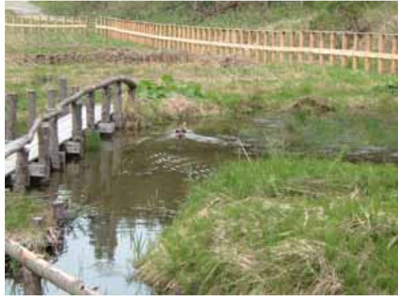
大畑沢転落防止柵設置 平成17年
