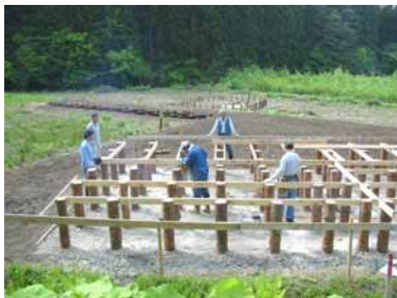
小屋基礎整備作業 平成15年
