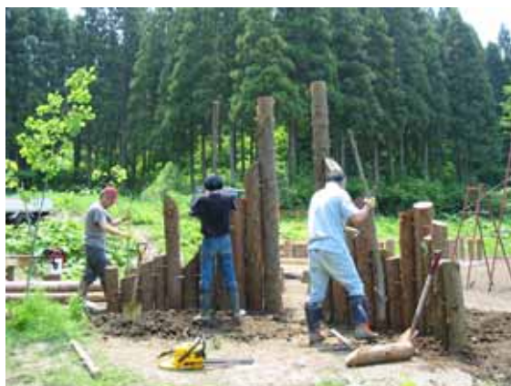
ゲート整備作業 平成15年
