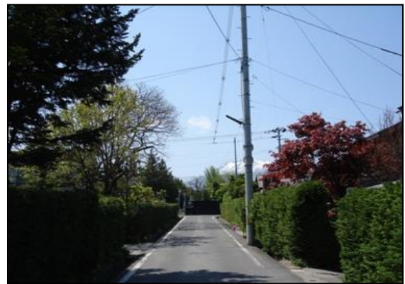
仲町伝統的建造物群保存地区内の電線（整備前）
