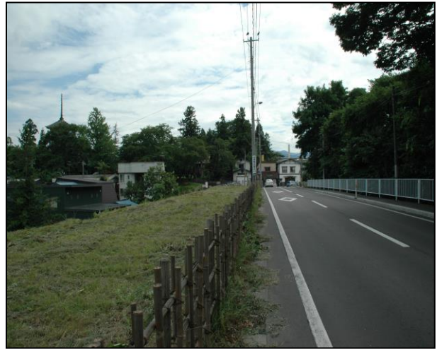
最勝院五重塔付近の狭幅員の歩道（整備前）
