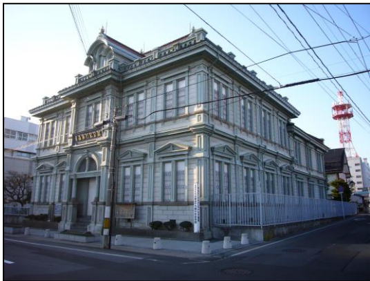
旧第五十九銀行本店本館前の電線
