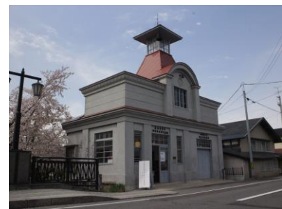
津軽塗技術保存会の研修活動拠点となった旧消防屯所
