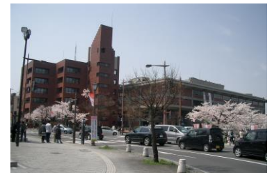
弘前市役所本庁舎
