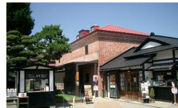
修理後の旧藤田家別邸倉庫
