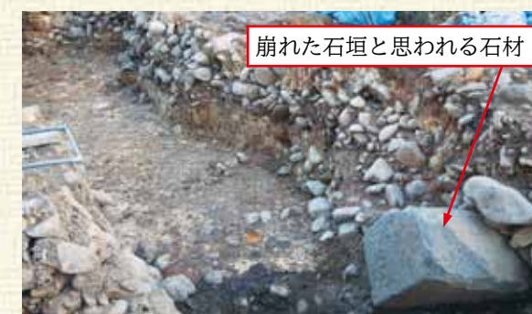
△明治～大正時代に石垣崩落部分を修復した盛土
