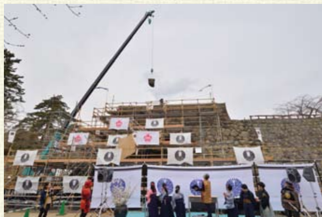
▲石垣解体始め式
