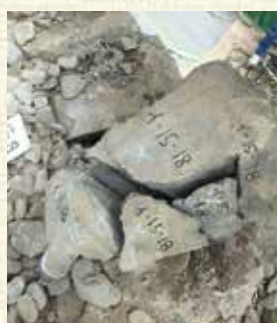
▲破損が著しく補修できない築石（※4）
