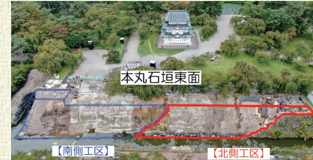
▲石垣積み直し工事の工区分け（※1）
