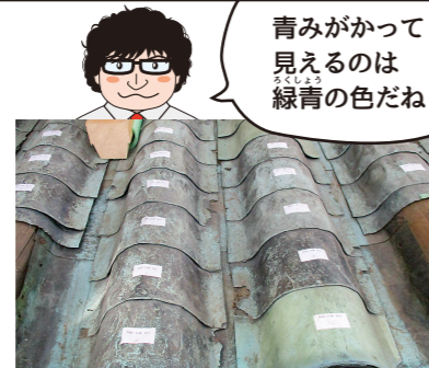
▲南内門2階屋根の南面に残る銅瓦葺 (江戸時代後期のものと推定)
