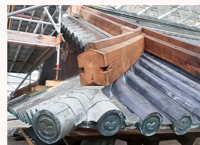
▲南内門2階屋根の北西隅(右側手前側が交換した部分)
