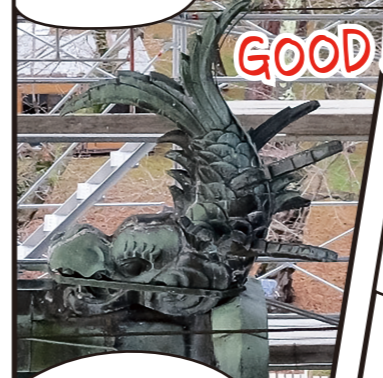
▲追手門・東側の鯨 木彫りの腐食状況
