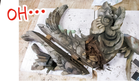
▲追手門・東側の鯨 木彫りの腐食状況
