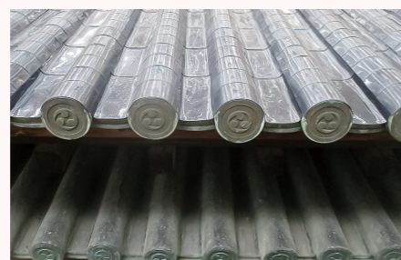
▲南内門2階屋根東面(上段は銅板葺替後、下段は今回修理しなかった窓底)
