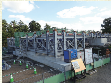
▲（※5）組立中の作業構台（本丸から天守台を望む）
