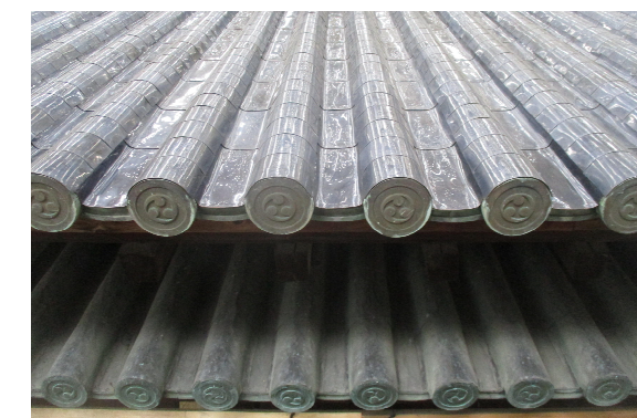
修理後の南門上層屋根 平側〔上〕と窓庇〔下〕
