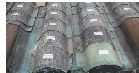
二の丸南門上層屋根妻側の銅瓦葺
