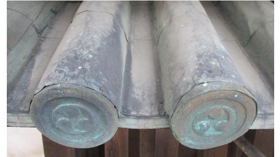
2階窓庇の銅瓦葺〔二の丸南門〕
