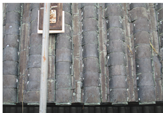
修理前の上層屋根南門 [追手門]
