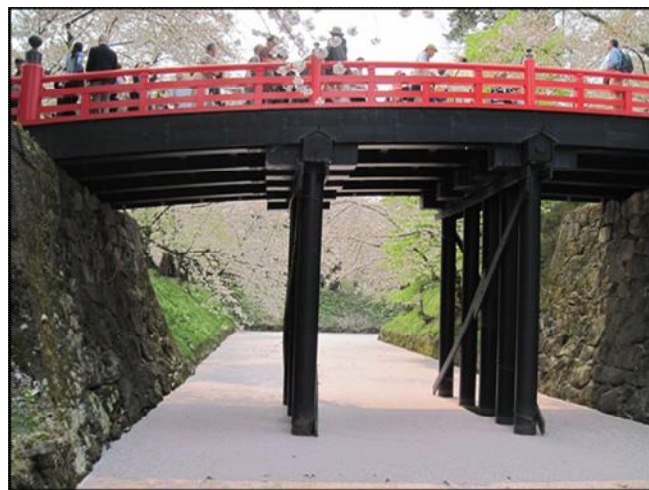
【写真5】 現在の下乗橋の脚部
