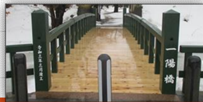
【写真4】 現在の一陽橋
