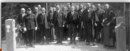
【写真3】 一陽橋渡橋式 <昭和8年>
