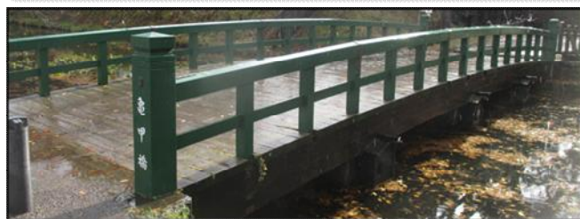
【写真2】平成16年<2004>仕様の亀甲橋
