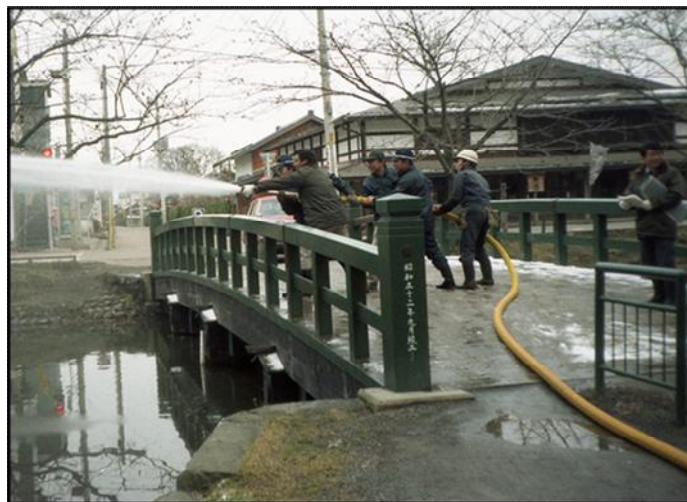
【写真5】昭和52年〈1977〉仕様の亀甲橋
