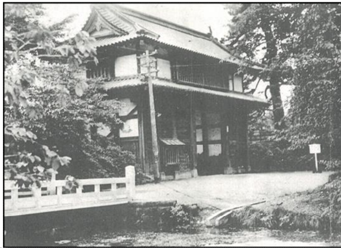
【写真4】昭和15年〈1940〉頃の亀甲橋 ※東奥日報社1940『青森県綜観』より転載
