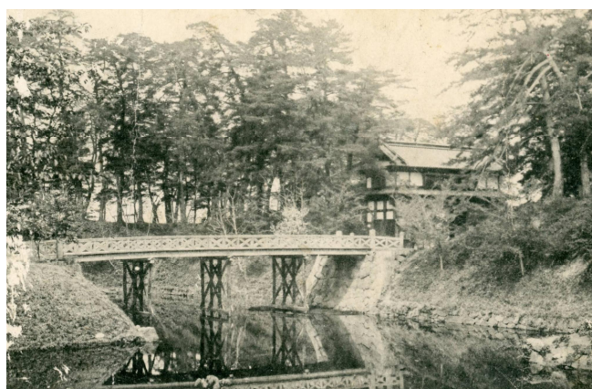
【写真5】明治末期～大正初期頃の杉の大橋
