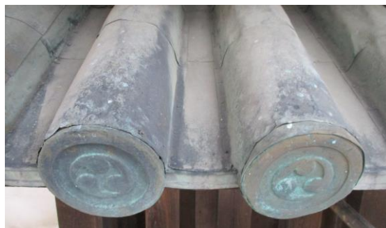
2階窓庇の銅瓦葺 [二の丸南門]
